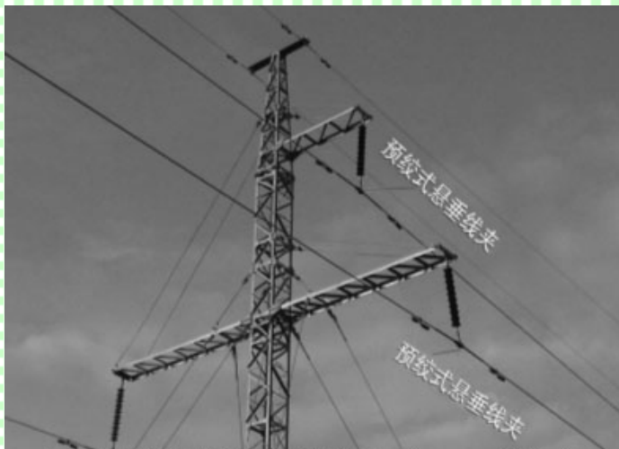
用于铝绞线的预绞式悬垂线夹用在 110KV 线路上
