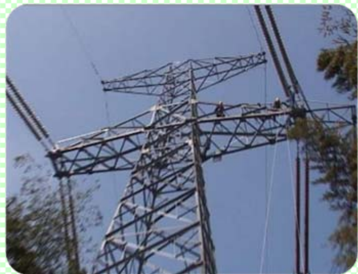
±500kV线路铁塔
